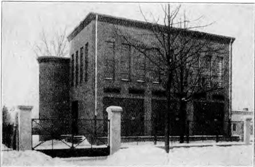
Abb. 6. Gleichrichter-Unterwerk der Bewag in Pankow, Idastrasse. (Erdgeschoss: Transformatoren, erstes Obergeschoss: Gleichrichter.)
