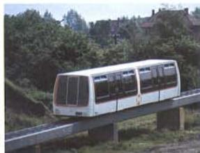
Aufgeständerte Strecken werden in Stahlbauweise oder aus Beton-Fertigteilen erstellt.
